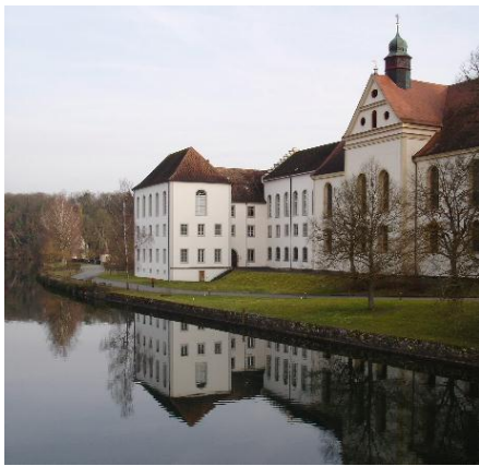
Annexbau Kloster Rheinau.
