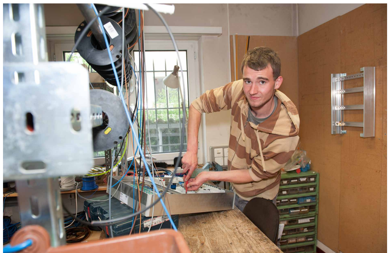
Patrick Dittli kontrolliert alle Verbindungen an einer von ihm gefertigten Schaltgerätekombination (Sicherungsverteilung). Danach wird sie in einem Neubau eingesetzt und sorgt für die sichere Verteilung des Stroms.
